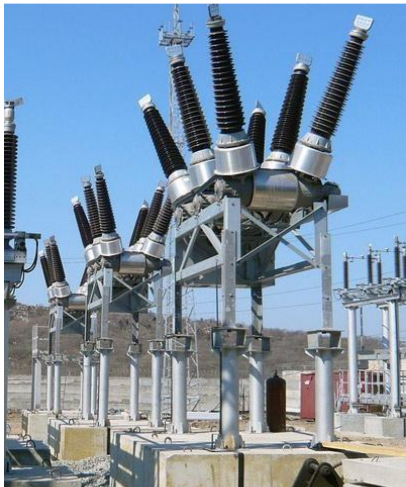
Рис. 9. Общий вид городской распределительной ПС 110/10 кВ мощность 25000 КВА
