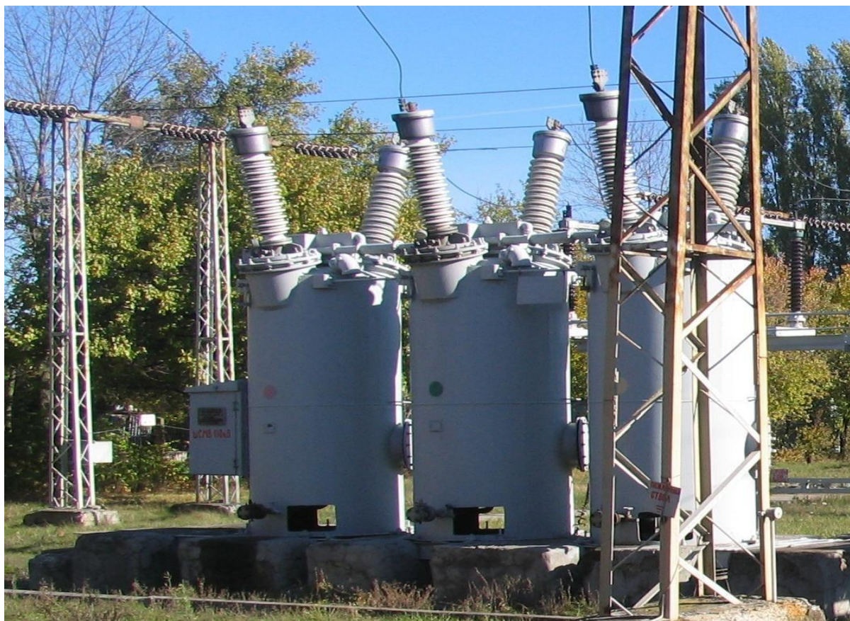
Рис. 5. Объёмные масляные выключатели 110 кВ
