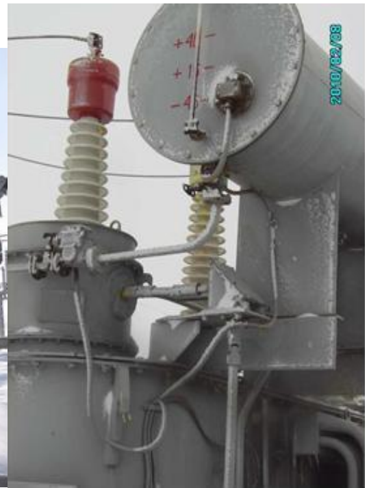
Рис.2. Маслонаполненный ввод 110 кВ
