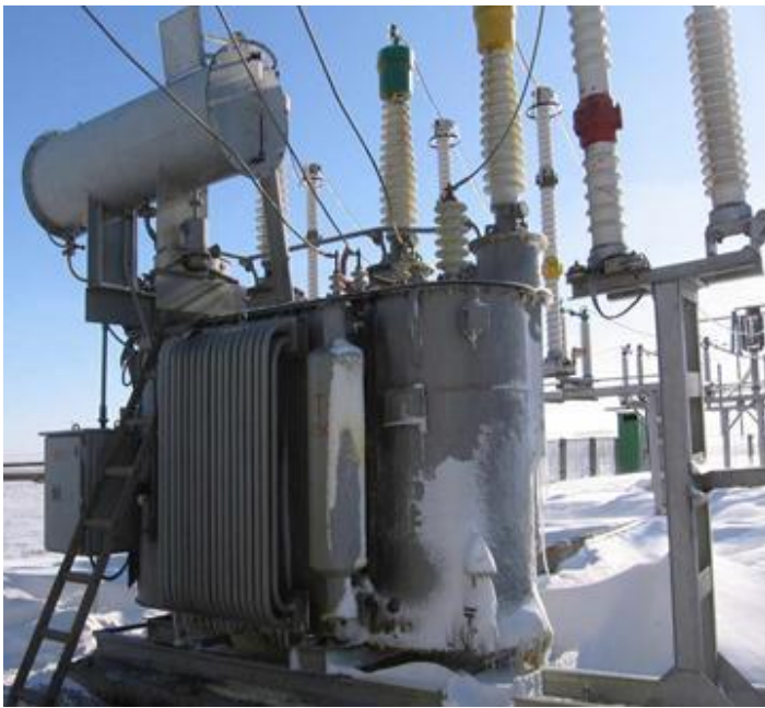
Рис. 1. Силовой трансформатор 110 кВ.
