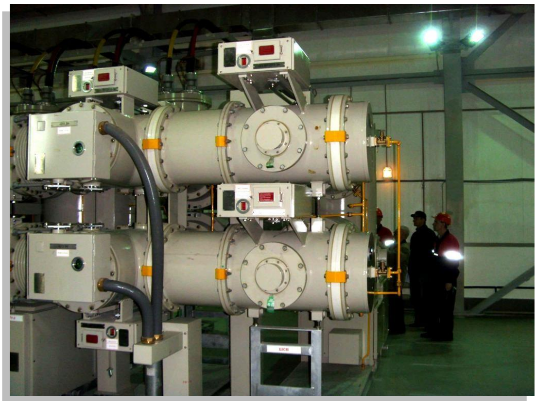
Рис. 8. Общий вид элегазового КРУ 110 кВ
