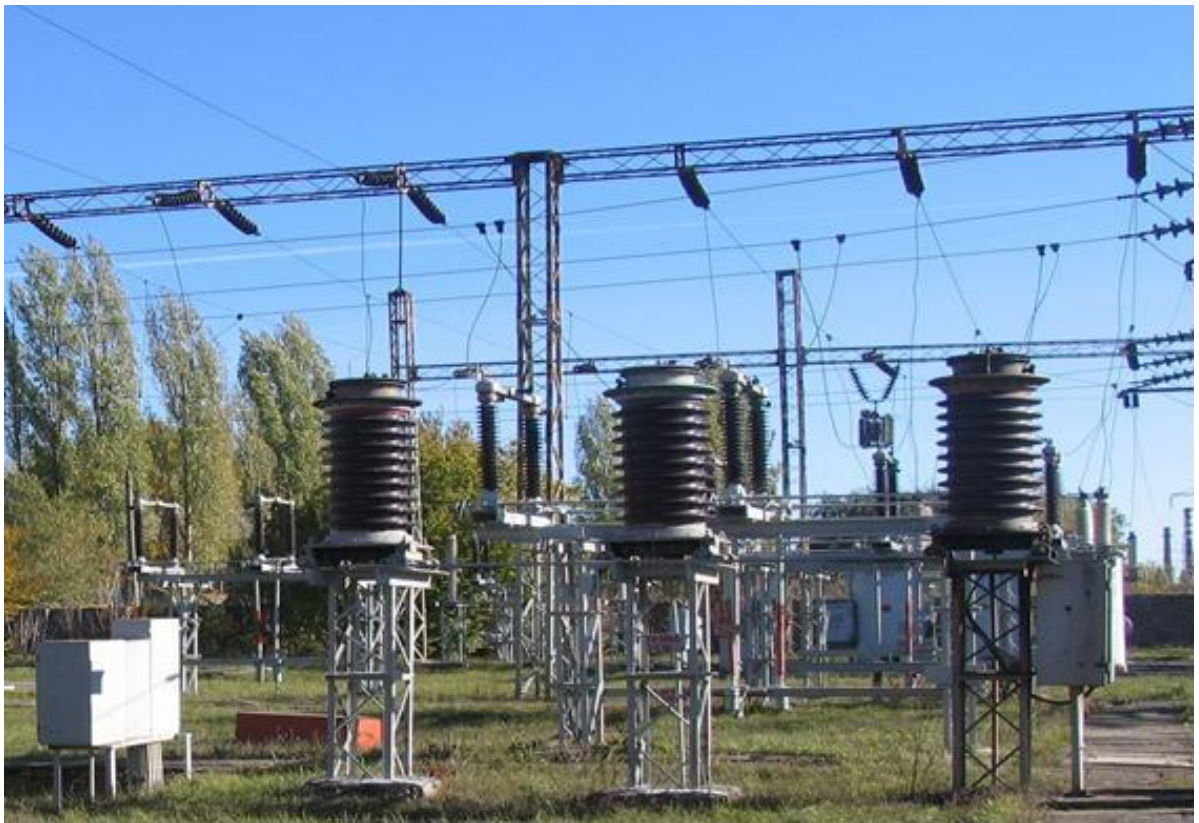
Рис. 7. Маслонаполненные трансформаторы напряжения 110 кВ
