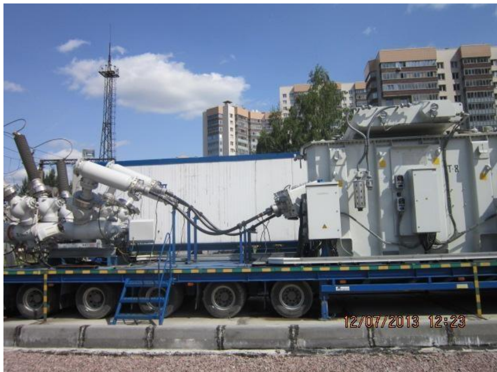
Рис. 9. Общий вид городской распределительной ПС 110/10 кВ мощность 25000 КВА
