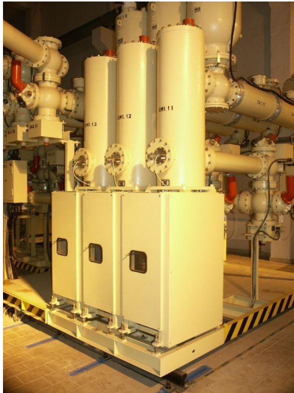
Рис. 5.1а Распределительное устройство с элегазовой изоляцией.
